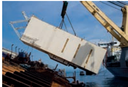
Het eerste caisson staat op het punt aan het schip bevestigd te worden.
